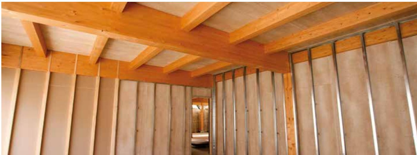
Il sistema in gesso fibrato Rigidur, composto da lastre in gesso additate con fibra di cellulosa e da accessori dedicati, è un sistema completo per la costruzione di pareti, contropareti, rivestimenti di attici e massetti a secco.
