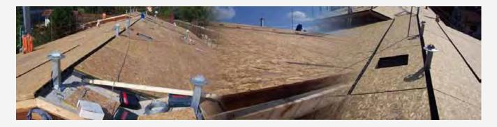
Per quanto concerne la posa dei pannelli, nel caso del monodirezionale, si dovrà disporre il pannello **Winpor** con il lato lungo parallelo alla linea di gronda in modo da ottenere le camere di ventilazione aperte e continue verso il colmo.
